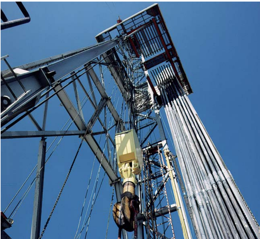
Blick in einen Bohrturm
