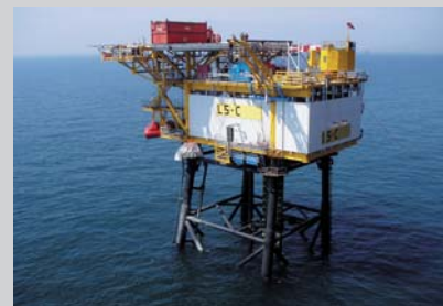
Anreizsysteme für Exploration haben in verschiedenen Nordseeanrainerstaaten zu einer deutlichen Steigerung der Suche nach neuen Lagerstätten geführt. Hier eine Erdgasplattform in der niederländischen Nordsee..
