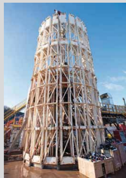
Bohrgestängelager an einer modernen Bohranlage
